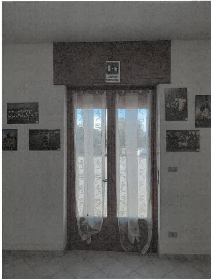
Foto 06: Particolare serramento da sostituire – uscita di sicurezza
