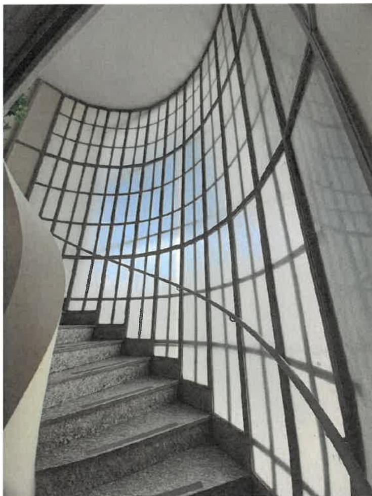
Foto 08: Particolare serramento vano scale da sostituire
