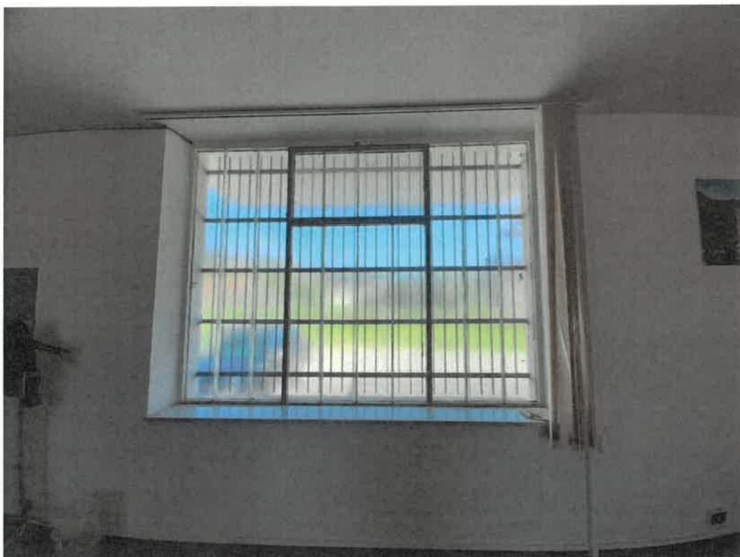
Foto 05: Particolare serramento sala riunioni da sostituire
