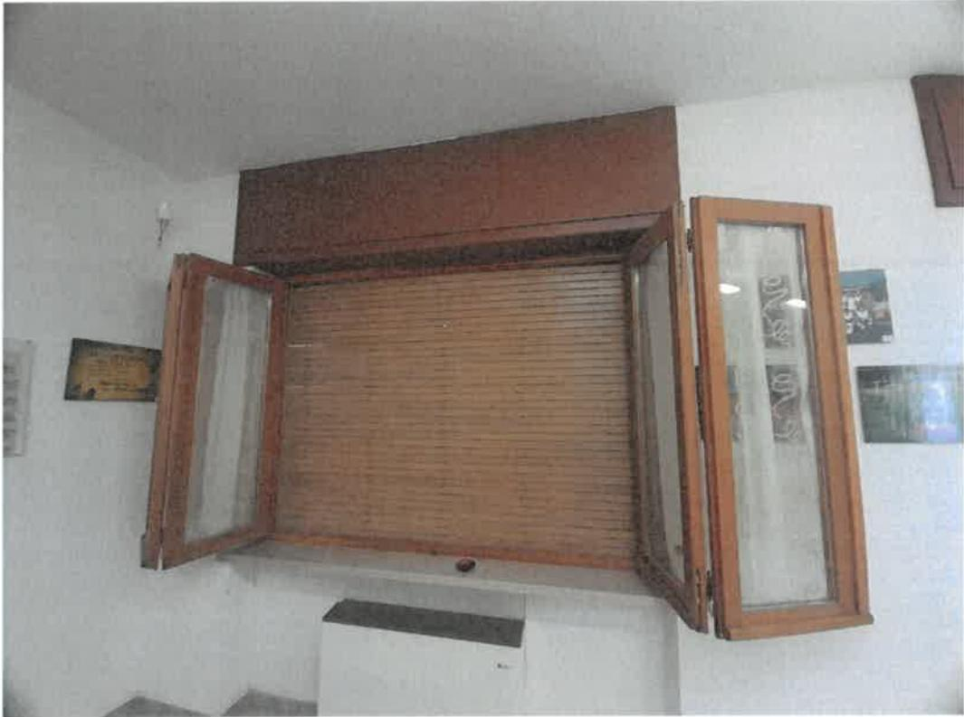
Foto 05: Particolare serramento da sostituire - apertura
